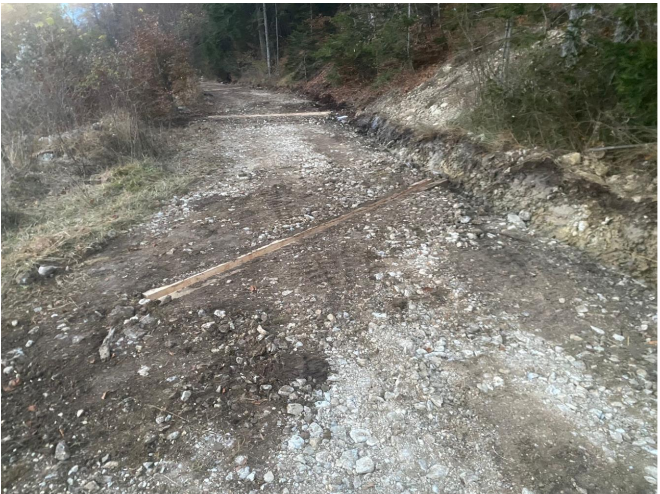
Sistemazione strada Tezze
